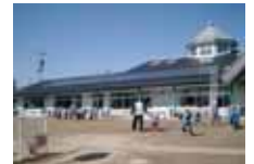
市民出資による 太陽光パネル設置
